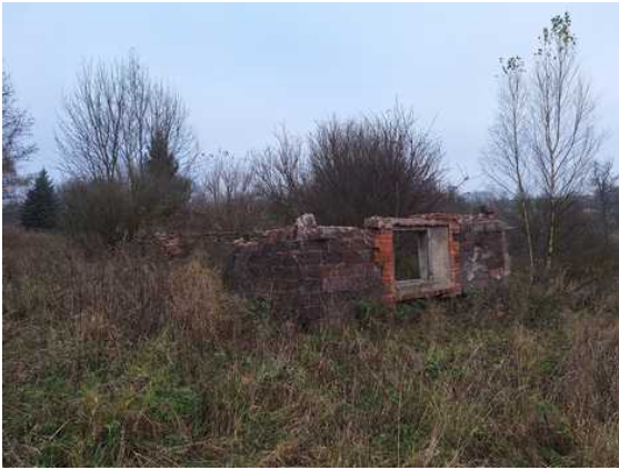
- zbořeniště na p.č.1382
