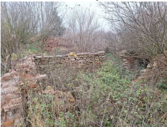
- zbořeniště na p.č.1382
