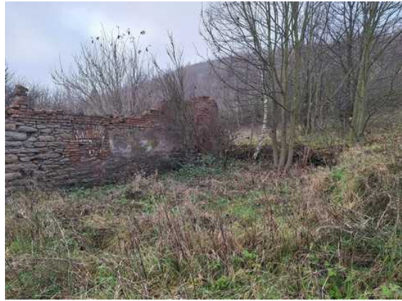
- zbořeniště na p.č.1382
