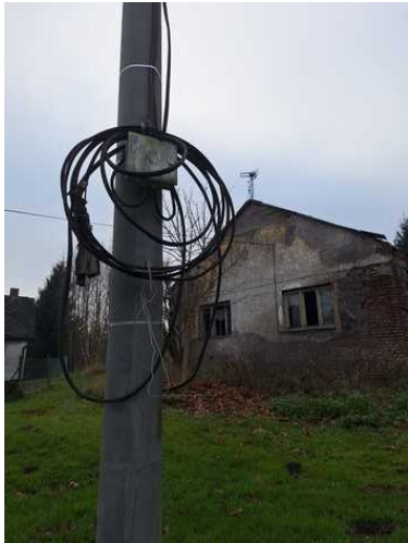
- ukončení přípojky elektro
