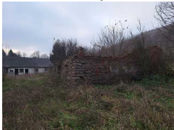
- zbořeniště na p.č.1382
