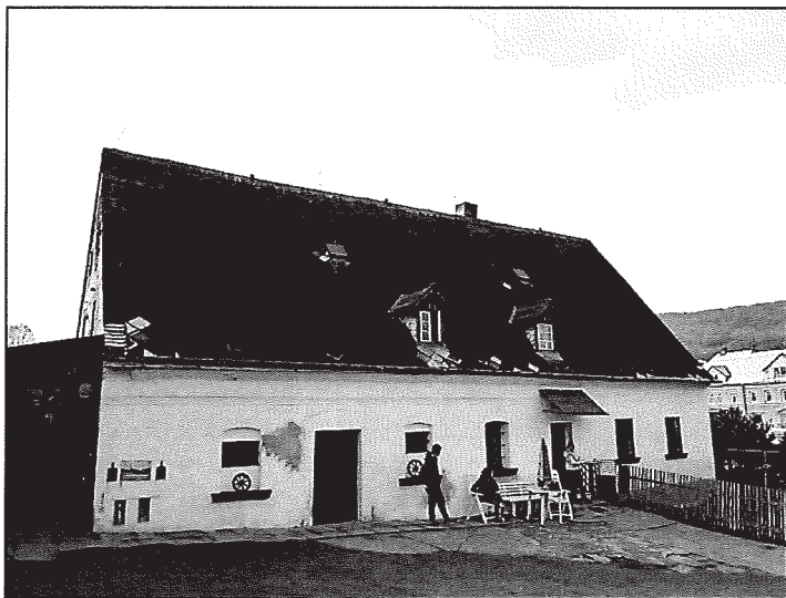
Pohled na dům ze dvora
