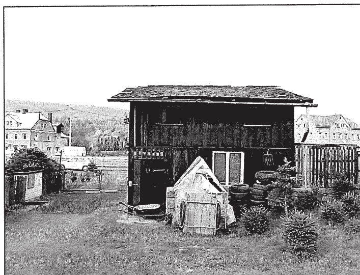
Pozemek p.č. 268/1 v majetku obce Libouchec užívaný s oceňovanými nemovitostmi vč.dřevěné kůlny na daném pozemku.
